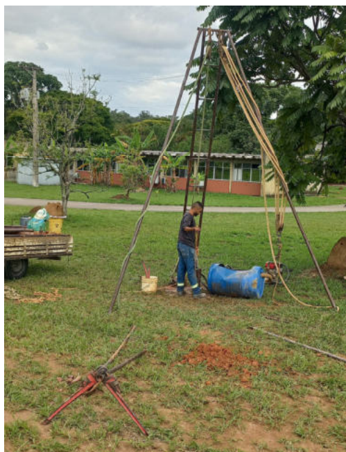
Sondagem do solo e levantamento topográfico do local onde será realizada a obra Construção da infraestrutura laboratorial das áreas de Metrologia Dimensional e Ensaios Não Destrutivos
