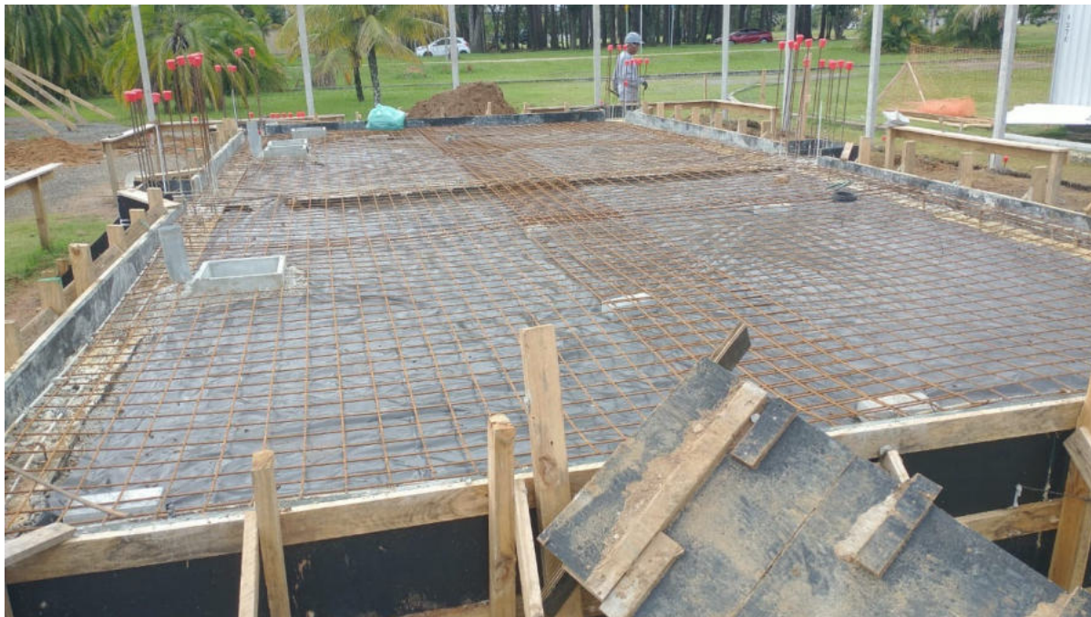
Estação Solo – Construção da Estação Solo do Centro Espacial ITA (CEI) com início em 12 de dezembro de 2025 e término previsto para 10 de abril de 2026.
